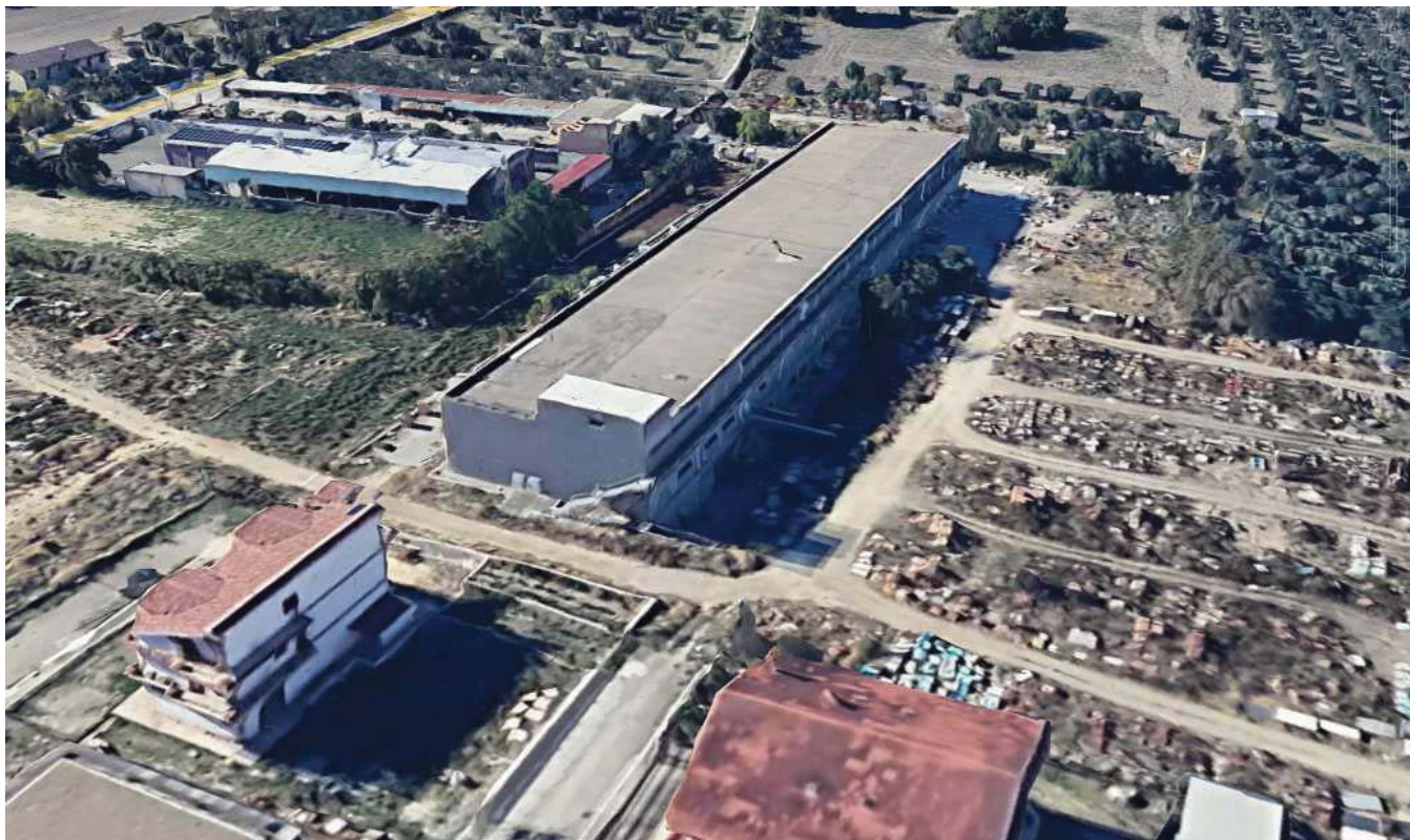
FOTO N° 1 – Vista aerea del capannone (da Google Earth TM ).
