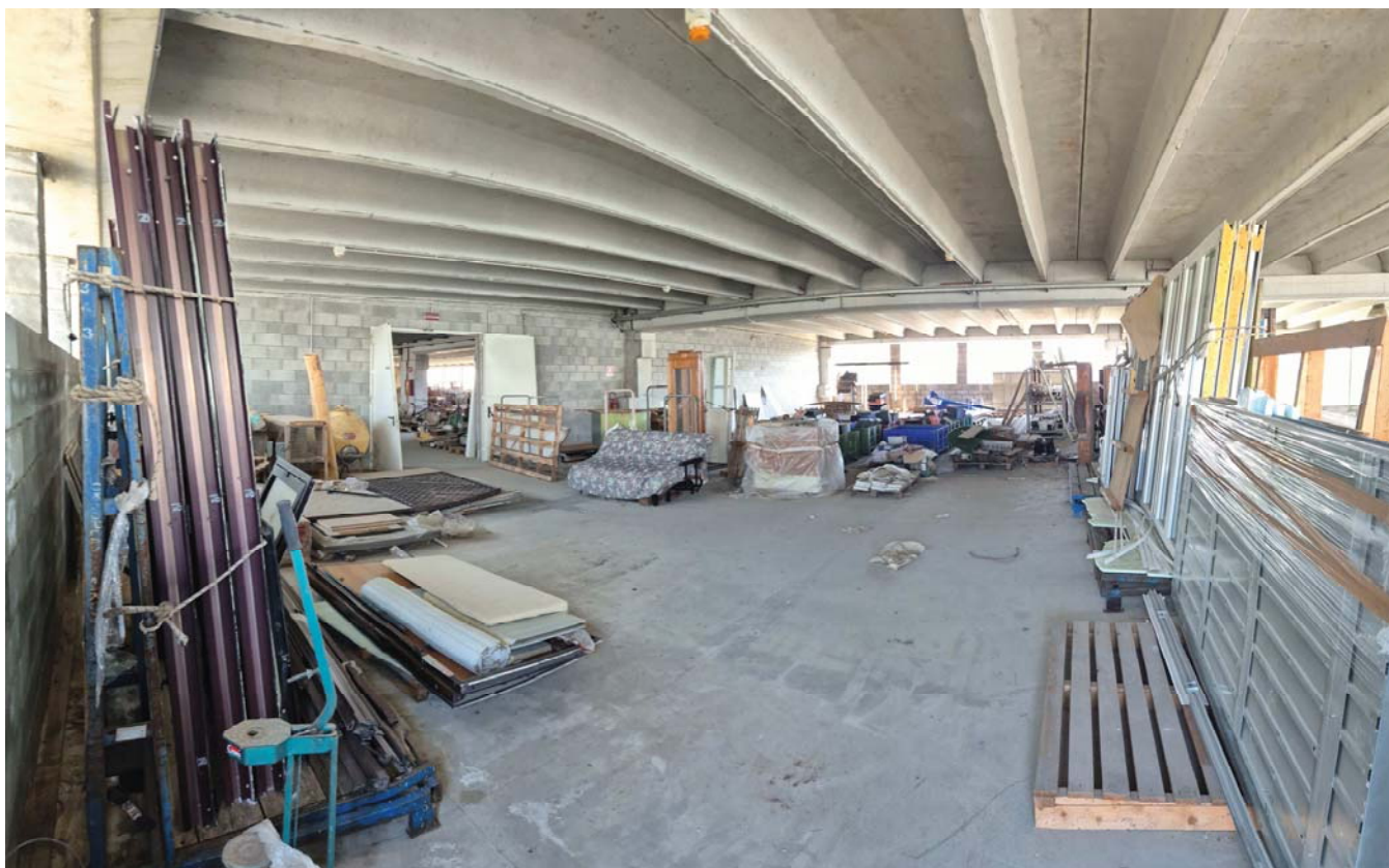
FOTO N° 6-7-8 – Vista della balconata lato nord-ovest e della zona del sub. 3 prospiciente sul piano terra sub.2.
